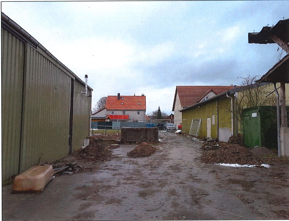
Foto 1: Zum Abriss vorgesehene Reithalle (links) und Lagerhalle (rechts) / 14.01.2026
