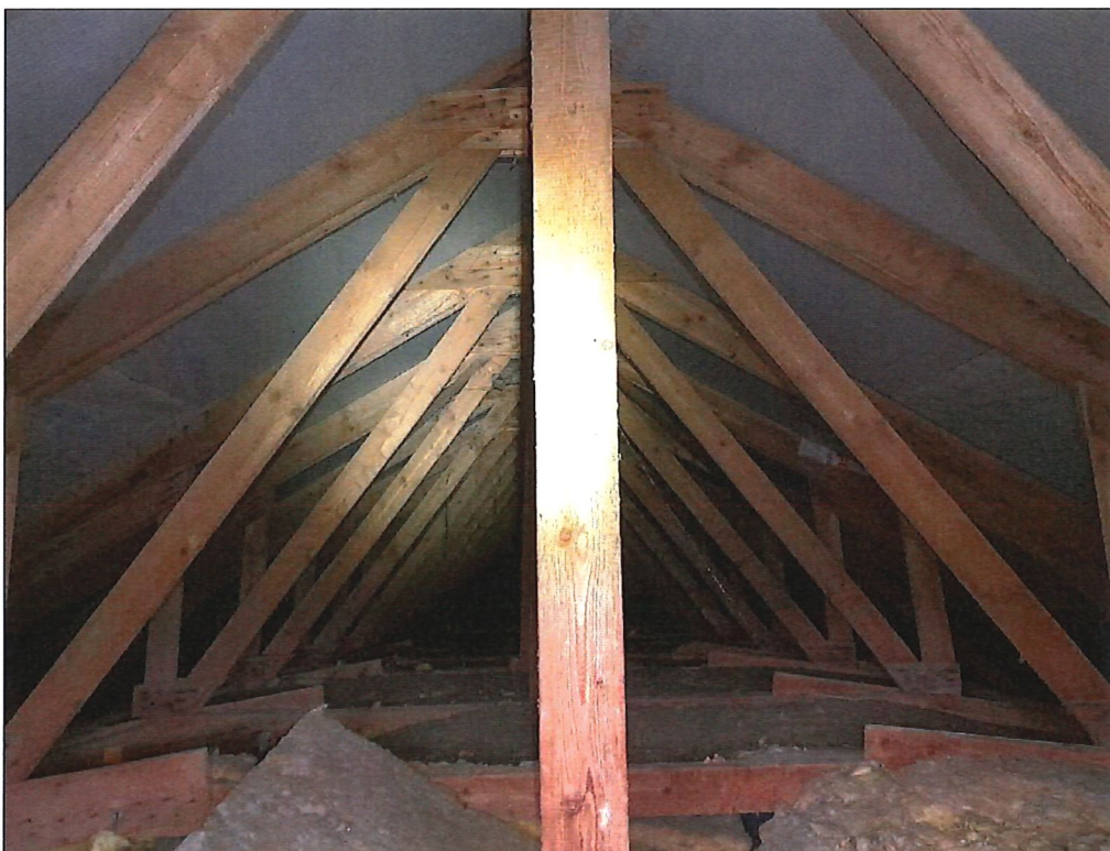
Foto 8: Dachgeschoss desselben Geb udes wie Fotos 6 und 7 mit Unterspannbahnen / 11.02.2026
